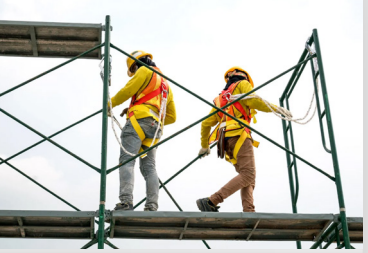
MONTAJE DE ANDAMIOS
